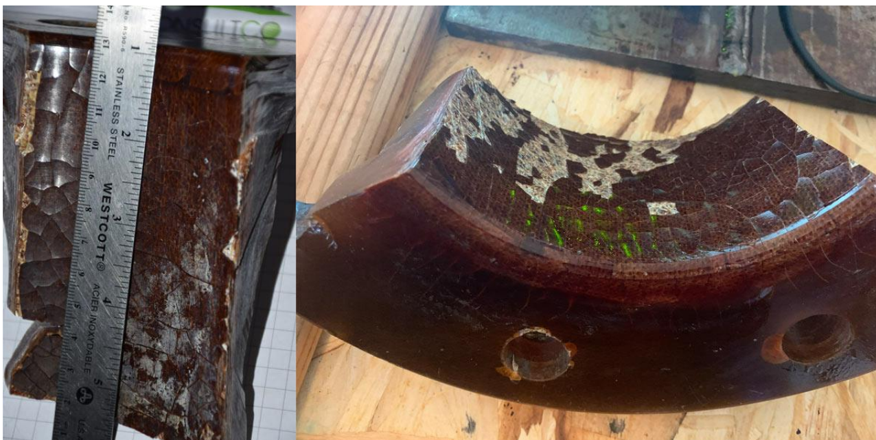
Figura 4. Condizione superficiale interna e corrosione dell'FRP
